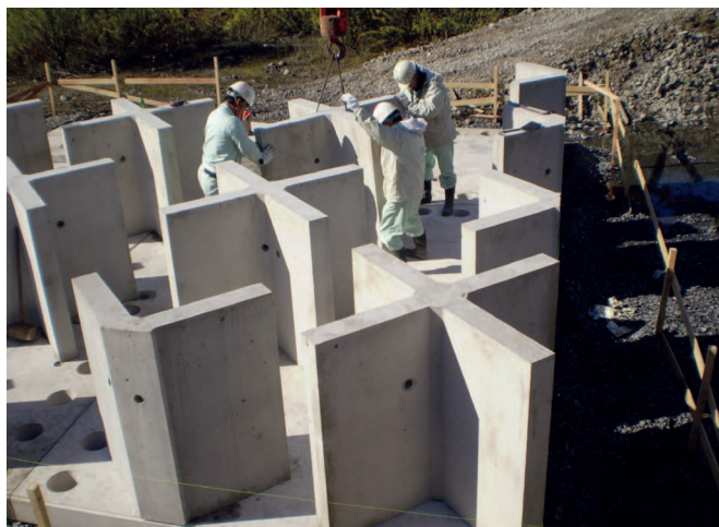
Рис. 5 и 6. Сборка крестообразного водонакопительного резервуара
